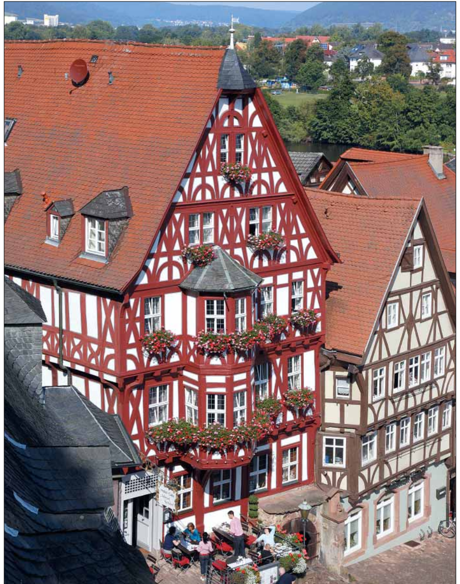
Nach der Renovierung ist das Hotel mit dem Erker, dem Freisitz und dem schönen Fachwerk ein wahres Kleinod.
